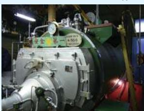
青年センターのボイラには約一トンの水が入っています。その水をどんどん熱すると、密閉された水室の中は七気圧、水温一四〇度にもなります。そこで、ボイラー上部の吹出口バルブを開くと高圧の水蒸気が猛烈な勢いで吹出します。この時の水蒸気の力は様々な形で利用されており、ピストンを動かして蒸気機関車や船舶の動力になったり、タービンをして火力発電や原子力発電の担い手となつたりします。
